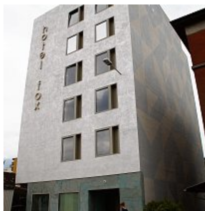
So sieht's mittlerweile aus.
